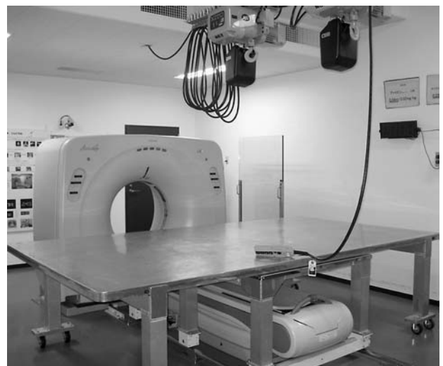
図1 帯広畜産大学の CT 装置 (Asteion Super 4、東芝)。CT 本体手前の台は大動物用寝台で荷重500kgまで耐える構造になっている。上部のクレーンで、麻酔下の動物を寝台に載せる。
