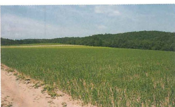
写真2 奥の頂上付近が切り土部分、手前が盛り土部分
