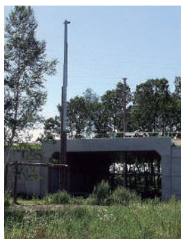
二本の支柱間を滑空して渡れる エゾモモンガ専用道路横断構造物
