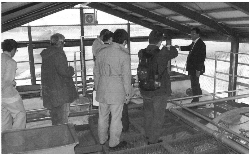
写真1 実証プラントの調査状況
