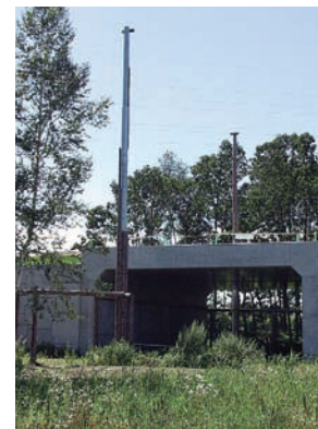
モモンガ用の道路横断構造物 A road-crossing structure for flying squirrels
