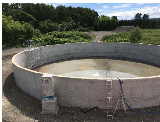
図 4.5 消化液貯留槽(敷地内)
