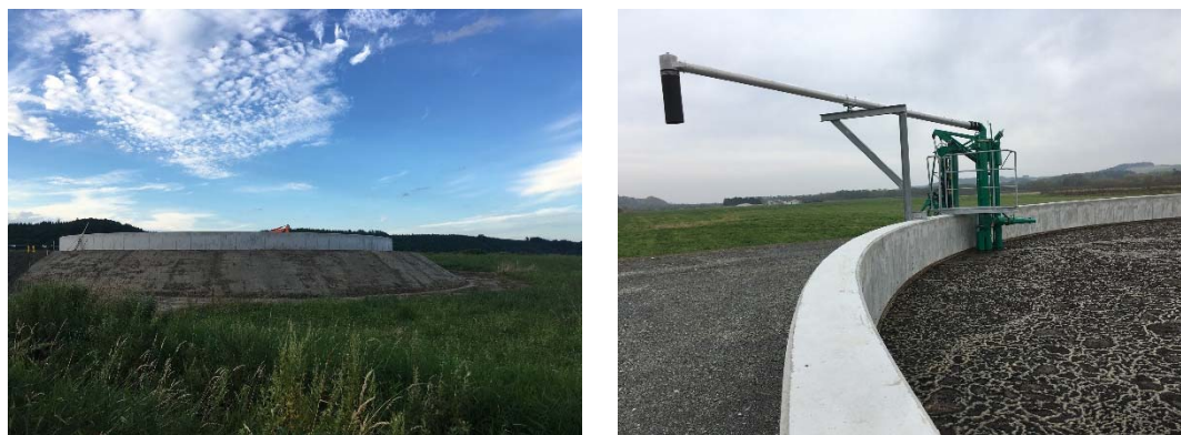
図 4.6 消化液貯留槽(敷地外)
