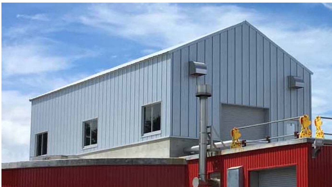
図 4.8 バイオガス貯留設備
