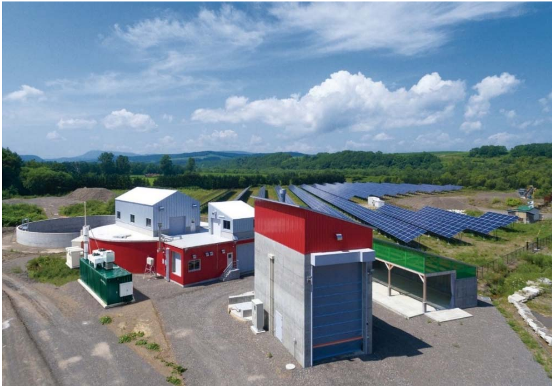
図 4.3 興部町北興地区バイオガスプラント全景
