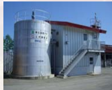
バイオガスプラント
