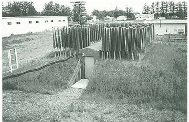
写真1. ヒートパイプを使用した永久凍土低温貯蔵庫（帯広畜産大学構内・1987年建設）
