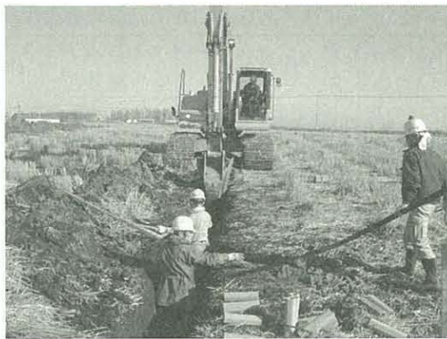
b) バックホーによる掘削
