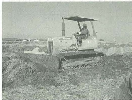
f) ブルドーザによる埋め戻し
