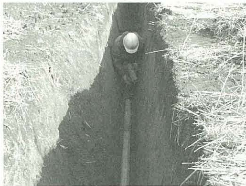
d) 手作業による土管の敷設
