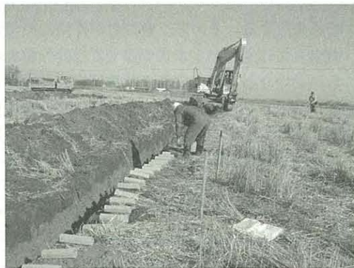
c) 補助作業による土管の整列
