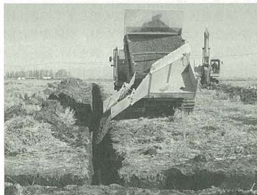
e) 疎水材(砂利)の投入
