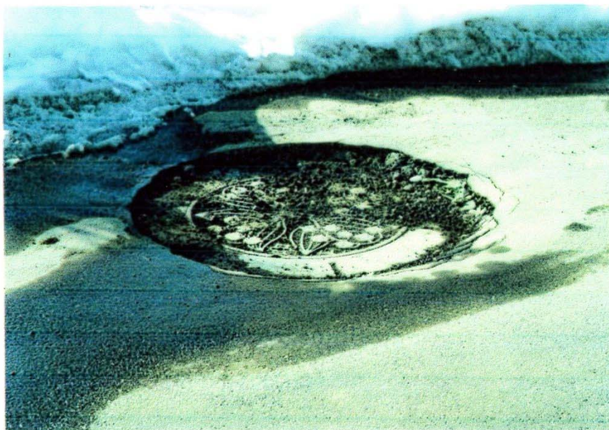
図-6.3.6 凍上した路面とマンホール鉄蓋の段差
