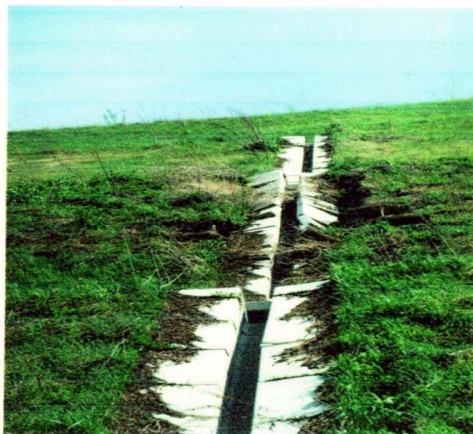
写真—2. 6 凍上と融解によって破壊された法面排水溝
