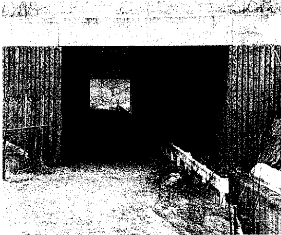
写真1. 池田町あらい沢川のボックスカルバート。壁面には半割りのカラマツ材が貼られている。
