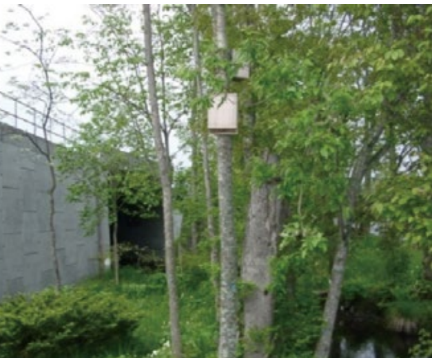
図4 垂直補強土壁で造られた高規格道路とその周囲のBat box。
