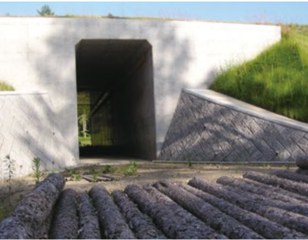
図5 エゾシカをブロックするための丸太を敷いたコウモリ用カルバート。
