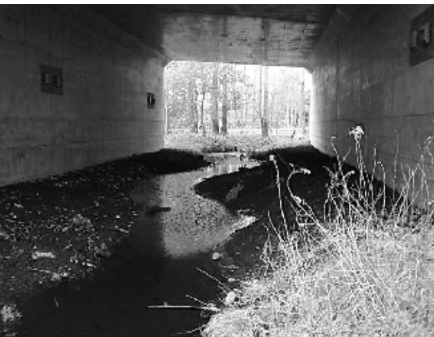
図3 門型カルバートとその中を流れる湧水の小川。
