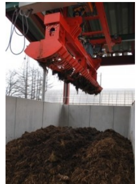
クレーンによる自動繰り返し装置
