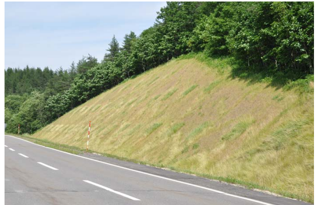
ミヤコザサを用いて緑化された道路のり面 (国道336号線大樹町紀文沼地区)
